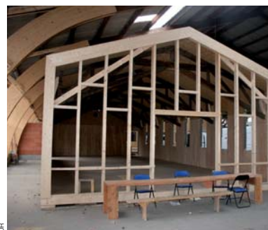
Sur une friche industrielle de l'île de Nantes, d'anciens hangars ont été réhabilités pour héberger les entreprises du pôle des Ecosolies.
